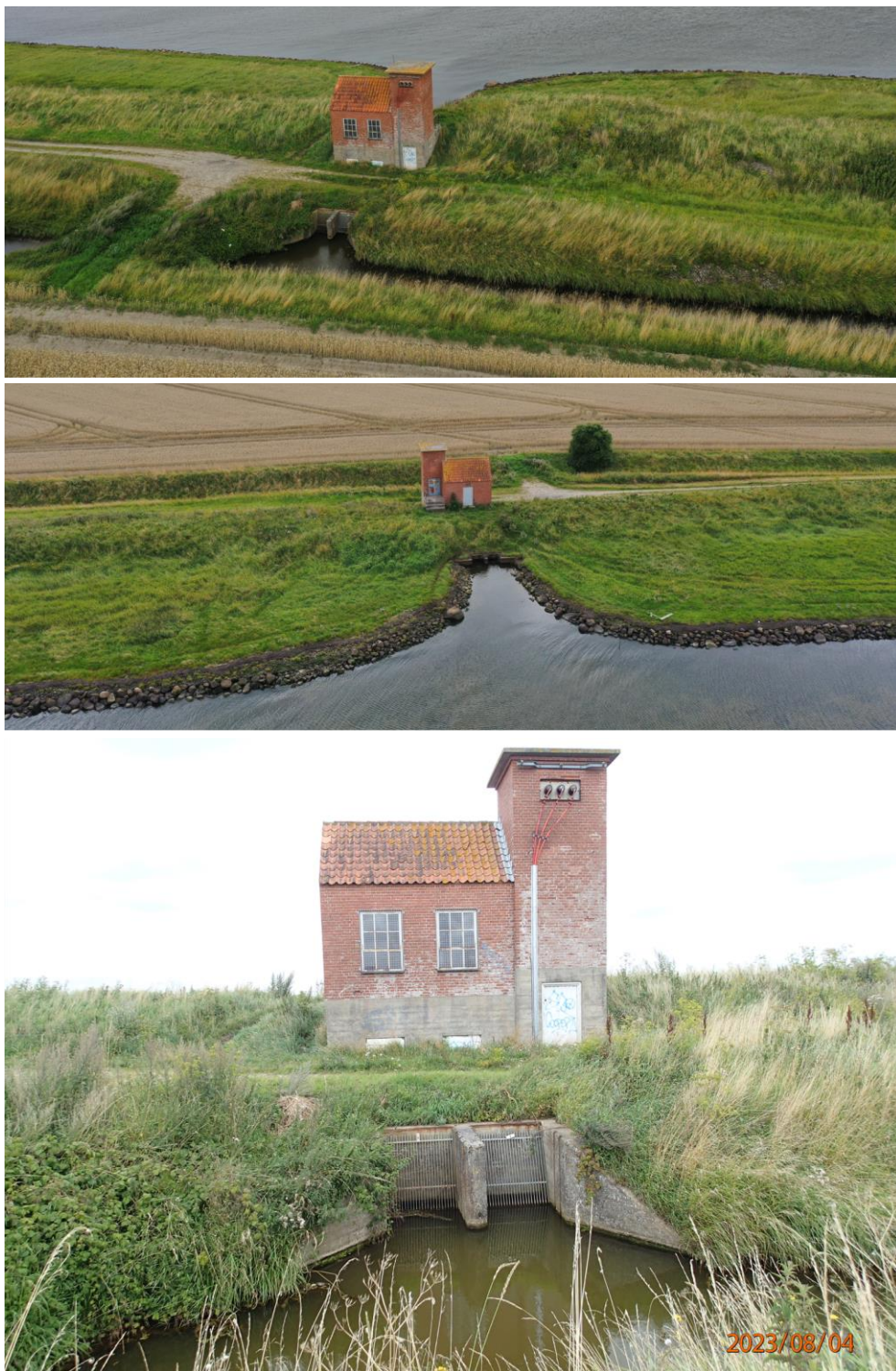
Figur 7-28 Pumpestationen fotograferet med drone fra syd (øverst) og nord (midt) samt nærbillede nederst.
