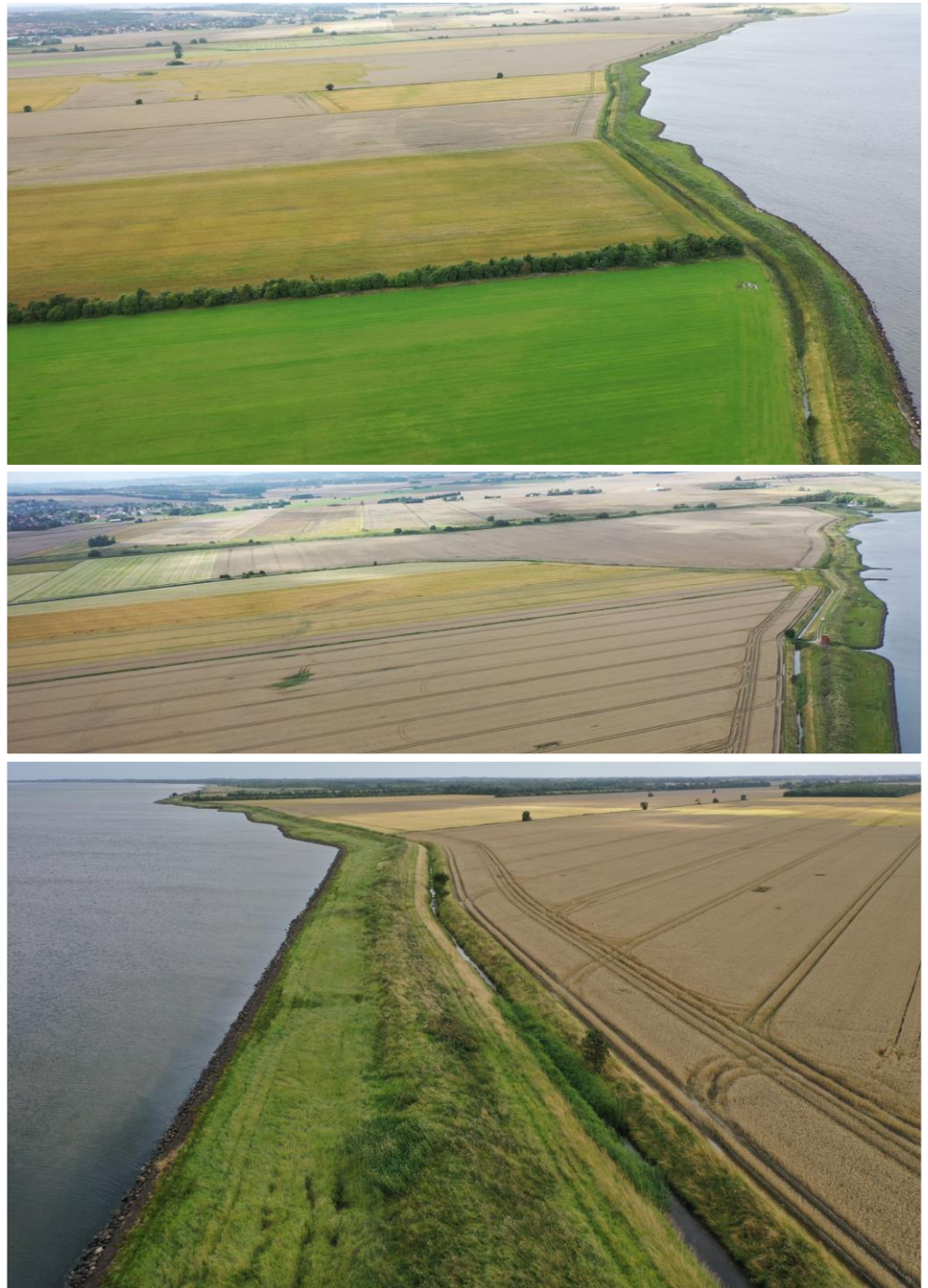
Figur 7-27 Mod nord grænser området op til Limfjorden, yderst med kystsikring og bag dette en smal strandeng, dige og kanalen, som bidrager til at lede drænvand fra de store marker til pumpestationen.
