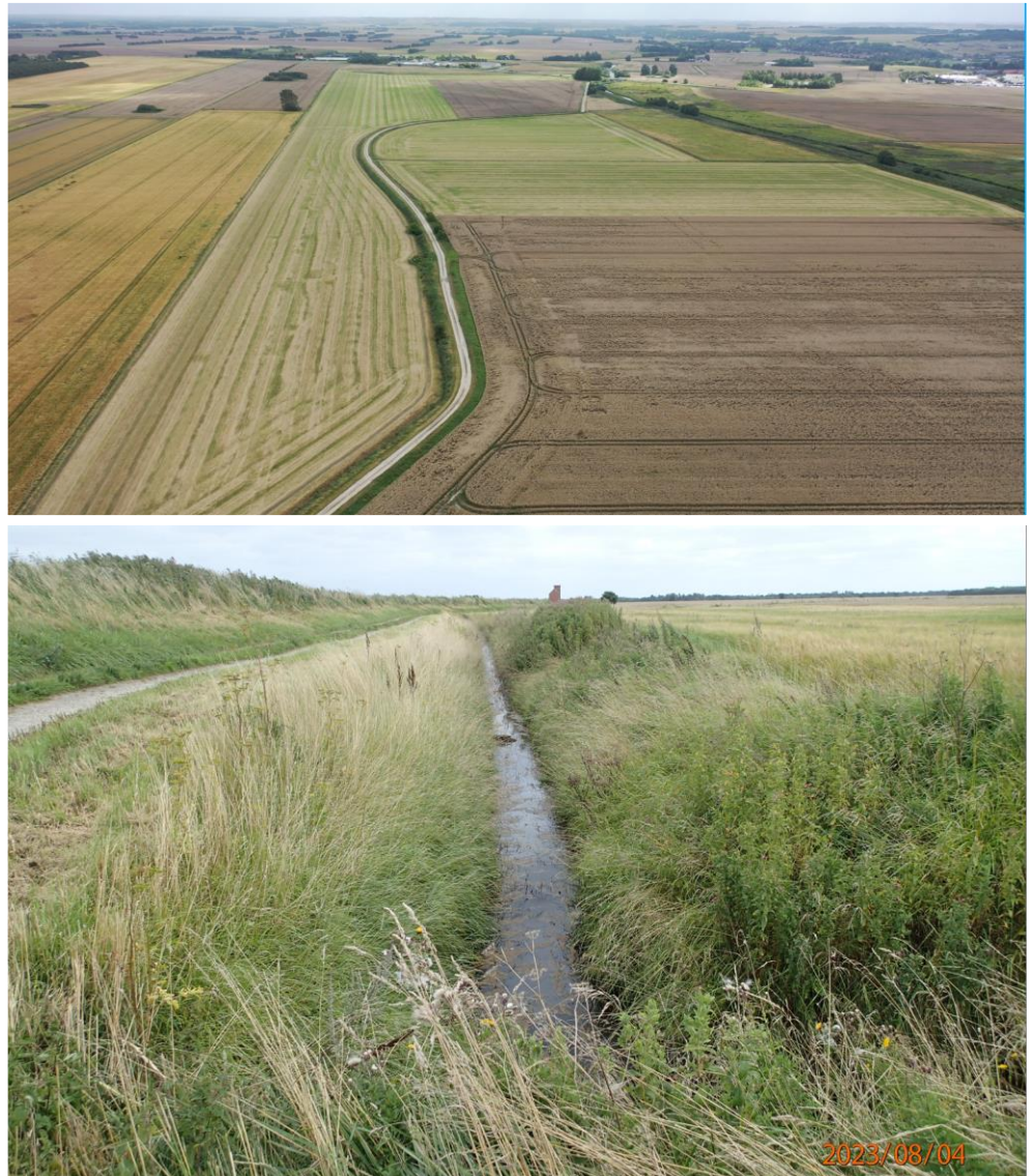
Figur 7-29 Dronefoto af den hævede vej gennem den vestlige del af området. Nederst grøften langs vejen i den yderste del mod pumpestationen.
