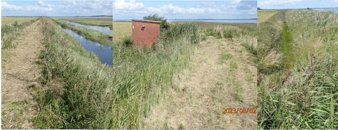
Figur 7-40 Fotos som viser diget, grøfter på inder og ydersiden af diget samt pumpestationen i den østlige del. undt om markerne. (Fotos: Torben Ebbensgaard).
