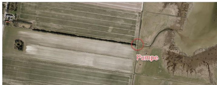
Figur 7-9 Placering af Pumpe i bunden af bugten ved Egense.
