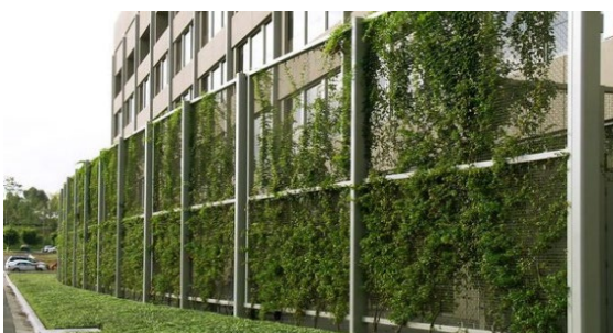
Figur 18: Eksempel på grønn fasade. Foto: Abitare
